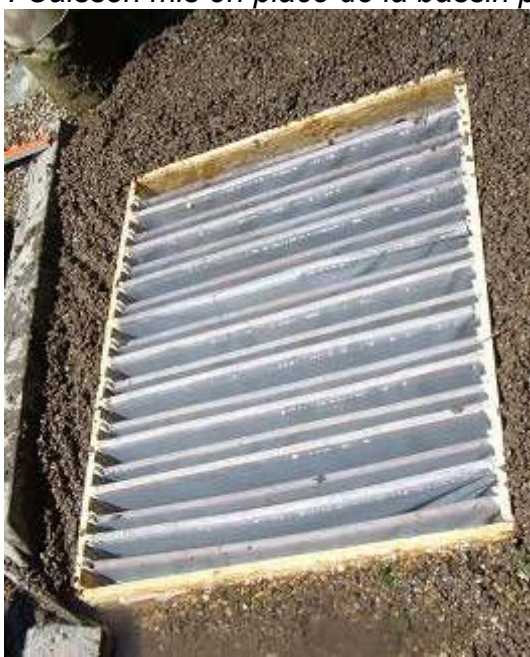
Photo 1 : Caisson mis en place de la bassin préconçu
