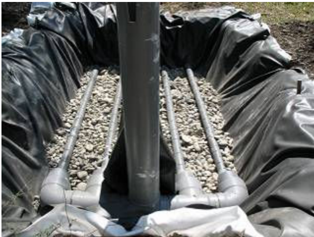
Pose de la tuyauterie et du lit drainant
