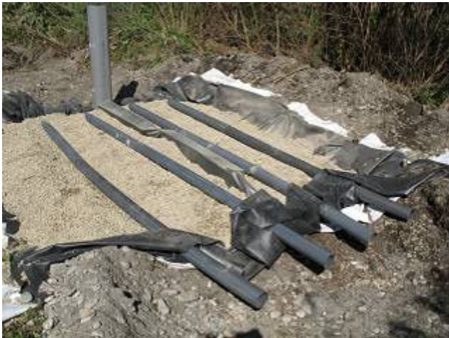
Remplissage avec le gravier et pose des drains de récupération
