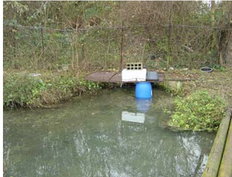
Installation de la pompe-doseuse à l'entrée du bassin de décantation
